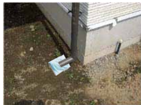
雨樋の下に土の影響を受けないように地面から浮かして置いた穴あきのプラスチック箱等に入れたゼオライトを置く
